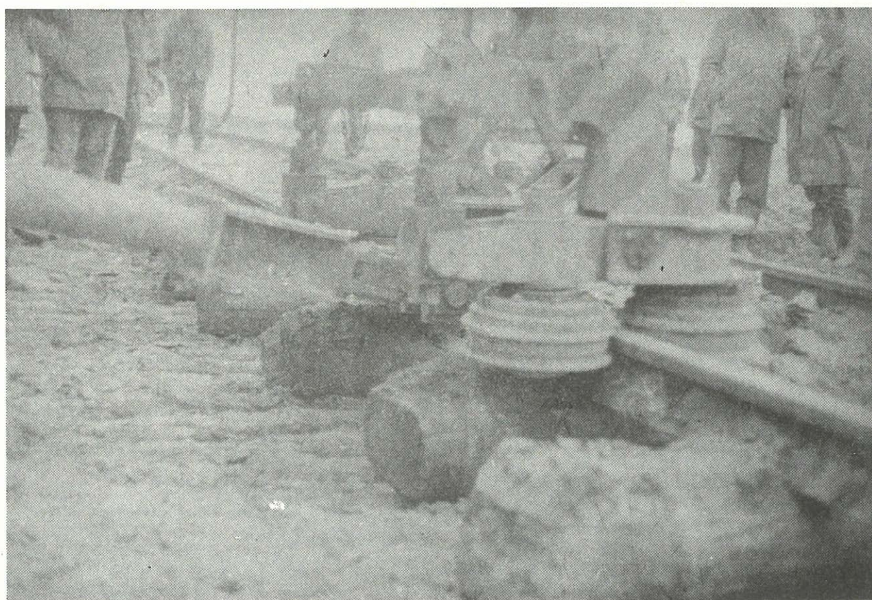
Obr. č. 1 Detail překládací hlavy a uchycení kolejnice pro překládání koleje turnodozerem
