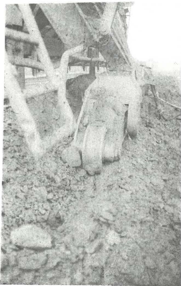
Obr. 4 příklad provozního stavu pojezdové dráhy drtiče nad DPD
