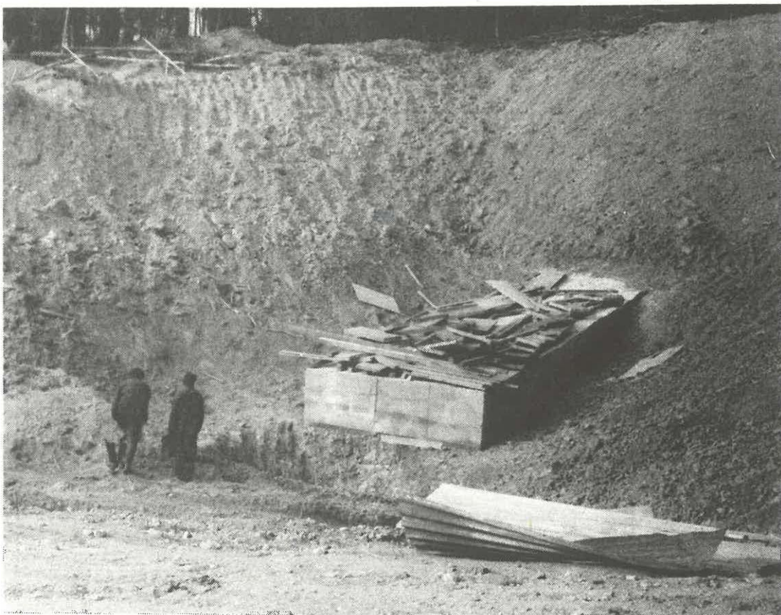
Obr. 3 Budování betonového žebra v západním křídle základové snáry těsnicí stěny v údolí Vesnického potoka
