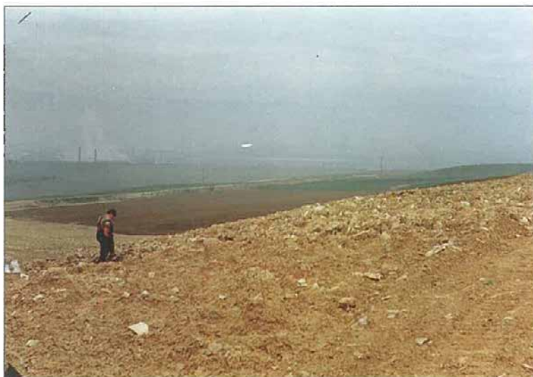
Obr. 3 Zapravování slínovců do povrchu výsypky Radovesice
