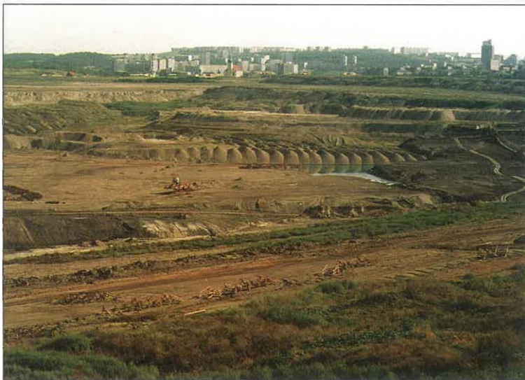
Obr. 3 Sanace zbytkové jámy lomu Most
