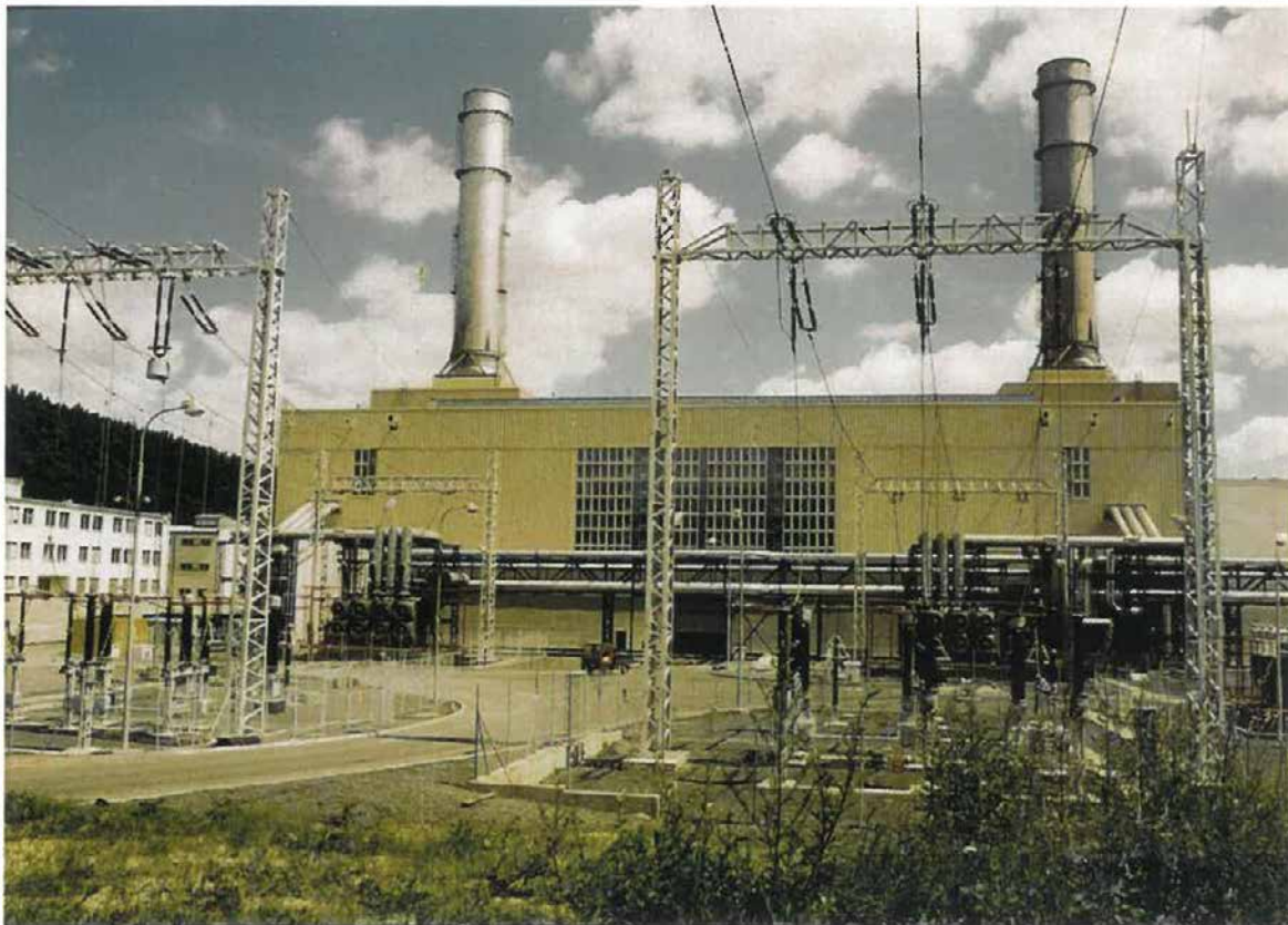
Dva 185 MW bloky paroplynové elektrárny ve Vřesové (dostavěno v roce 1996)
