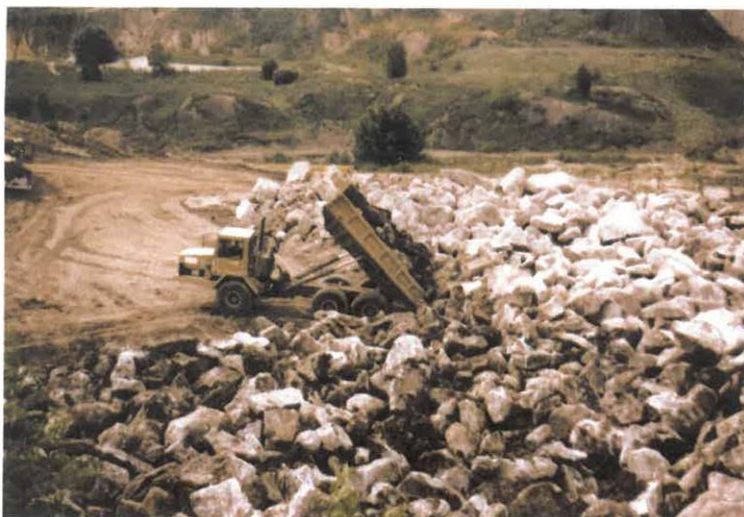
Obr. 8 Skládka pískovcových valounů využívaných při stabilizaci vnitřní výsypky
