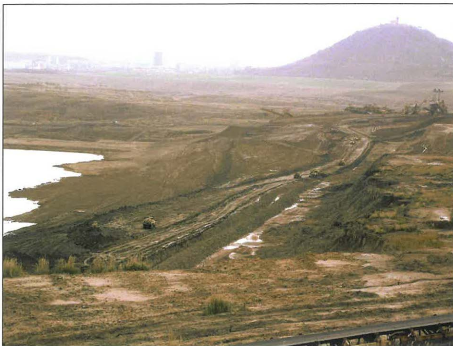
Obr. 2 Zakládání těsnícího tělesa uhelné sloje 1. etapy sanačních prací
