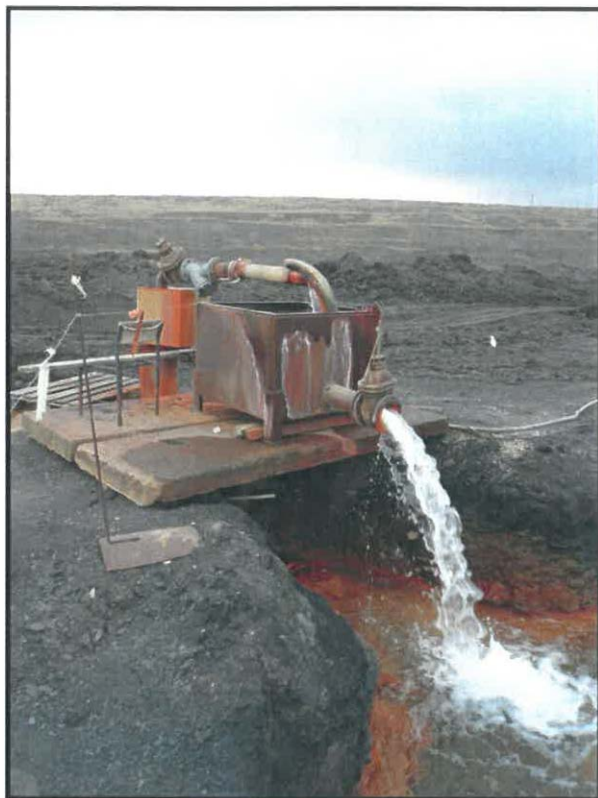
Obr. 3 - odvodňovací vrt STE 782-3A
