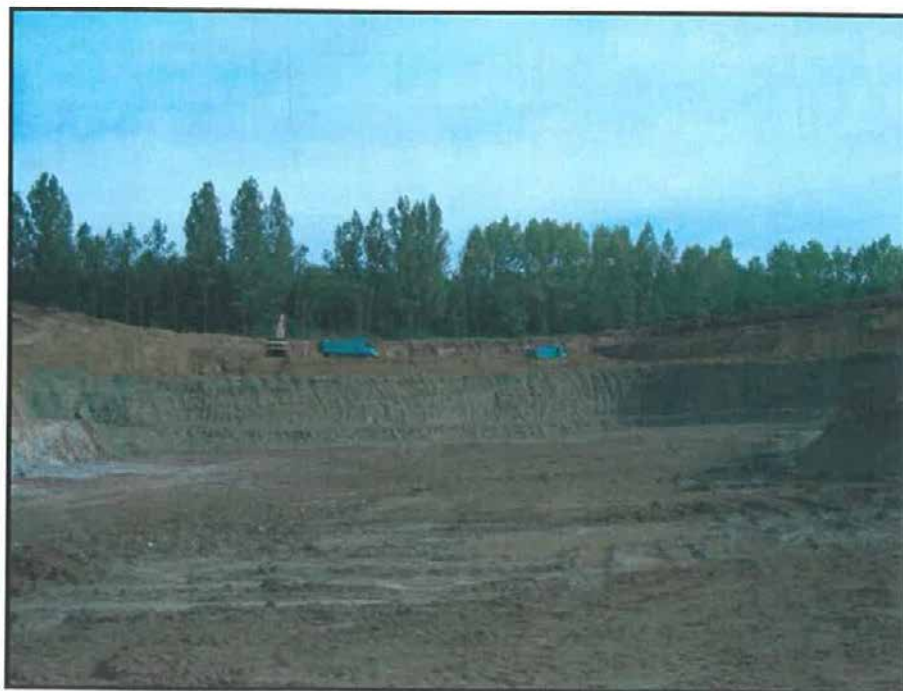
Obr. 1 - Situace ložiska bentonitů Černý vrch
