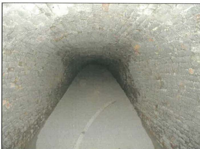
Obr. 5: Částečně zafoukaný profil štoly
