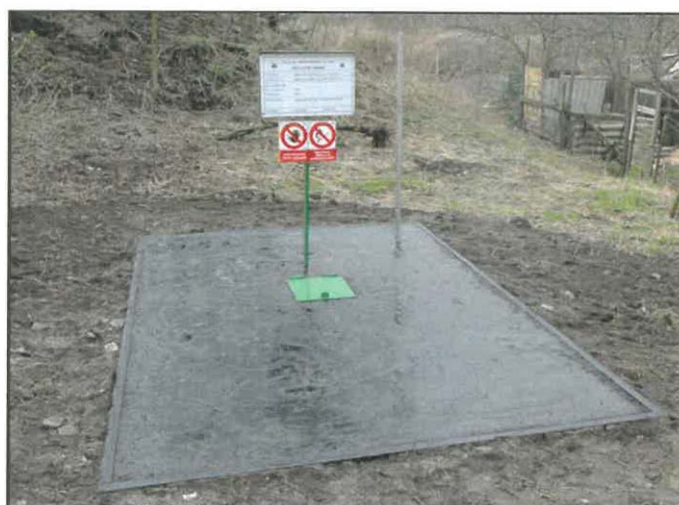
Obr. 7: Železobetonová deska nad vedlejším vstupem do štoly Jacobi I – konečný stav
