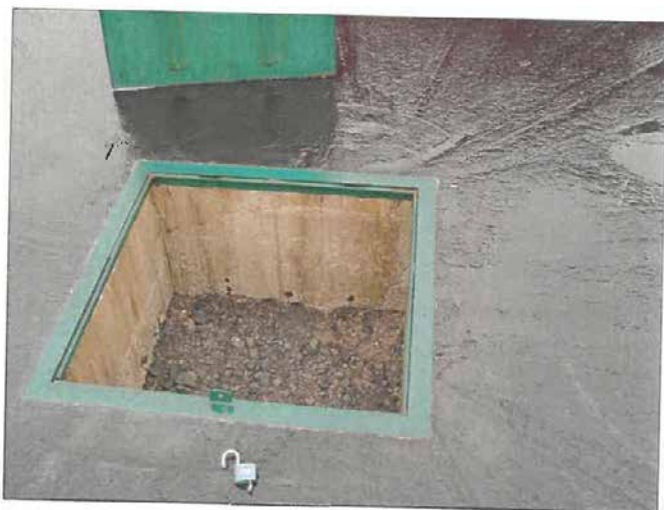
Obr. 6: Detail kontrolního otvoru s patrnou úrovní zásypového materiálu
