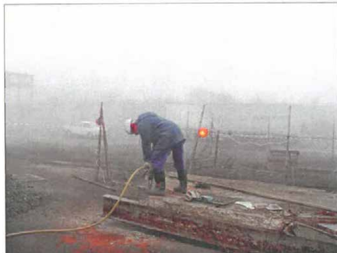
Obr. 3: Likvidace původní železobetonové desky
