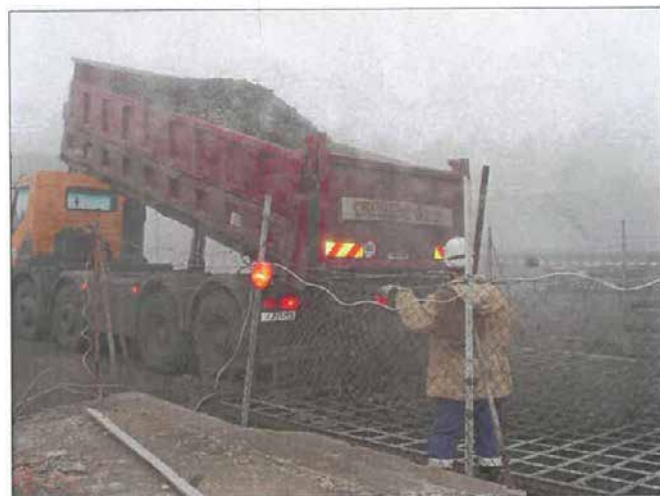
Obr. 4: Zásyp těžní jámy Kateřina neztvrdněným zásypovým materiálem
