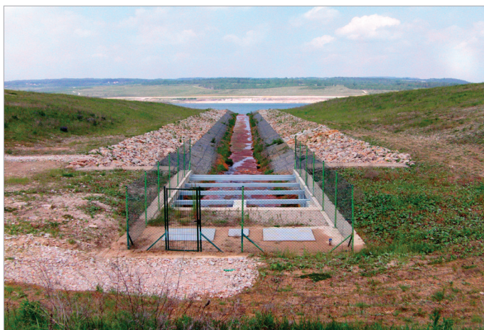
Obr. 4: Jímací objekt sloužící k napouštění jezera - 05/2012.
