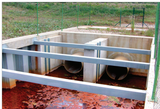
Obr. 5: Potrubí v místě křížení jímacího objektu s komunikací a železnicí - 05/2012.
