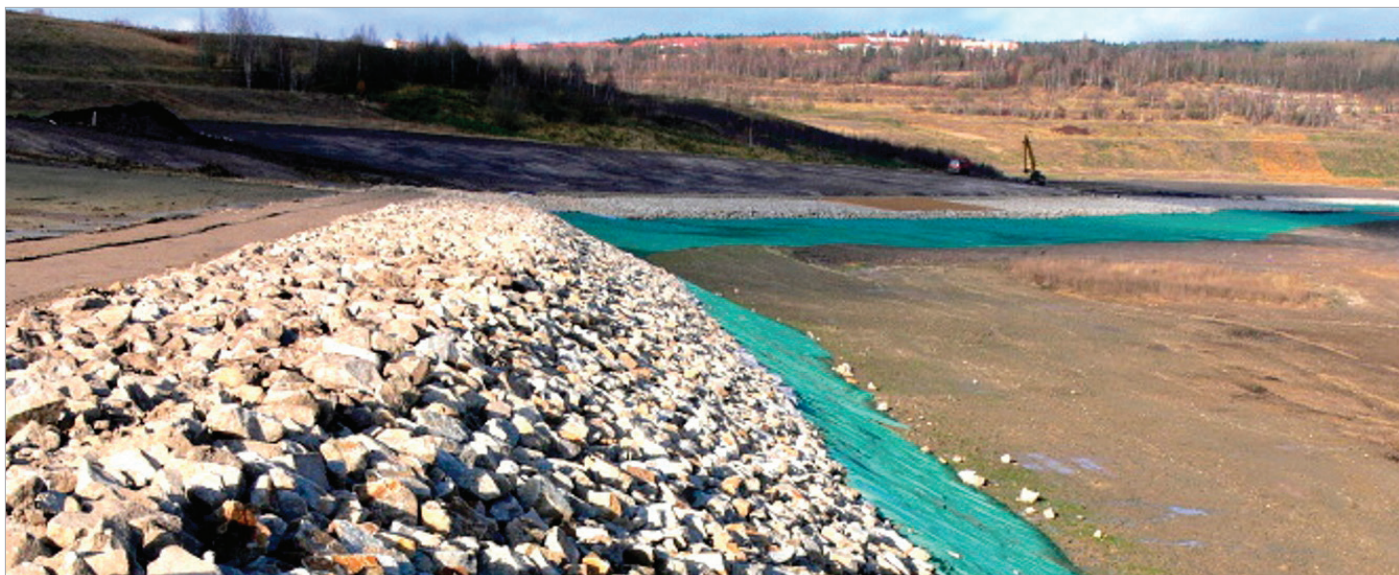
Obr. 3: Opevnění břehové části jezera - 09/2009.
