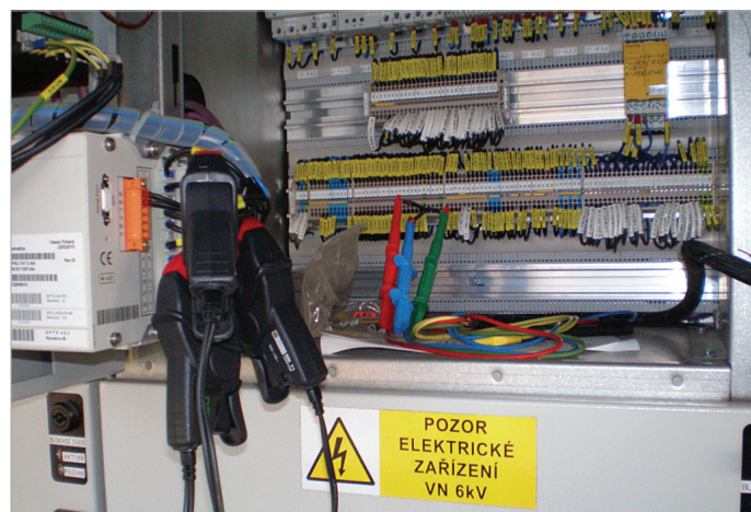
Obr. 2: Způsob připojení proudových a napěťových snímačů při měření.
