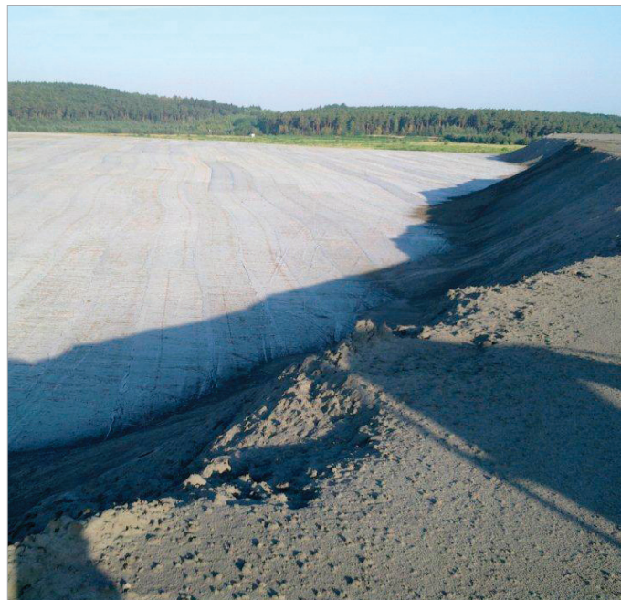
Obr. 1: Příklad využívání produktů po spalování pro tvarování terénu v lokalitě Mělník – Panský les.
