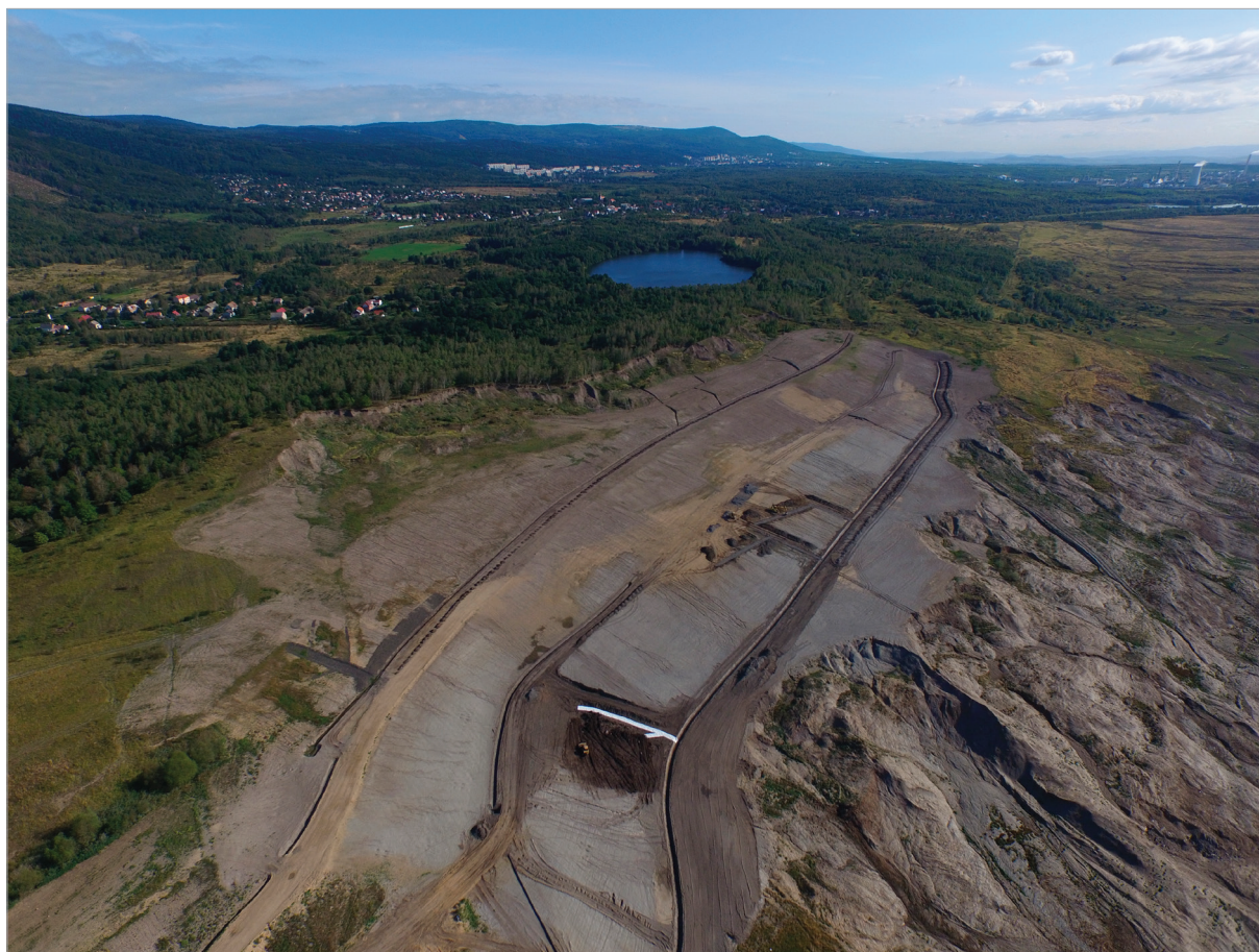
Obr. 5: Průběh sanačních prací na Albrechtické výsypce (Foto: J. Burda, 2015).
