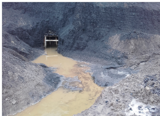
Obr. 3: Vtok vody do stařinového systému v severní části území.
