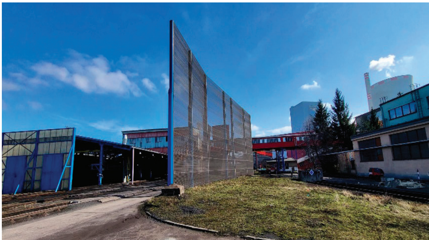
Obr. 6: Přední část protivětrné stěny u HZ I.
