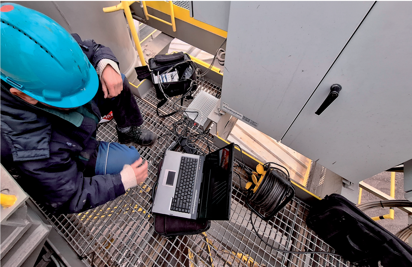
Obr. 6: Instalace měřicí techniky.
