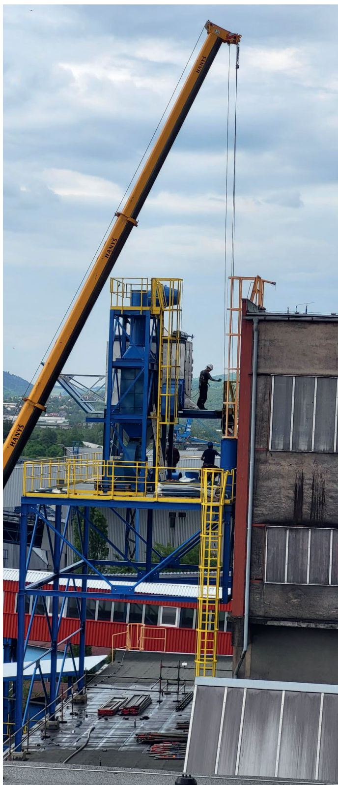
Obr. 6: Montáž filtrační části na OK.
